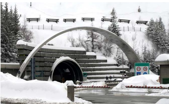
La différence de pression atmosphérique entre les deux extrémités du tunnel du Mont Blanc a un impact direct dans la gestion des équipements de ventilation.
